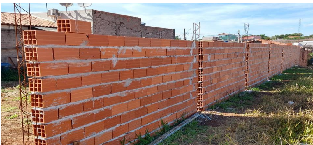
Figura 15: Programa habitacional “Meu Pedaco de Chão” com lotes dentro da malha urbana, restringindo sua expansão em áreas sem equipamentos públicos.
