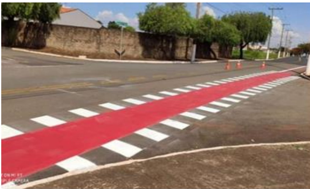
Figura 11: Instalação de ciclovias no município de Cordeirópolis-SP
